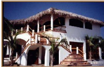
The house in Los Barrilies, Baja
